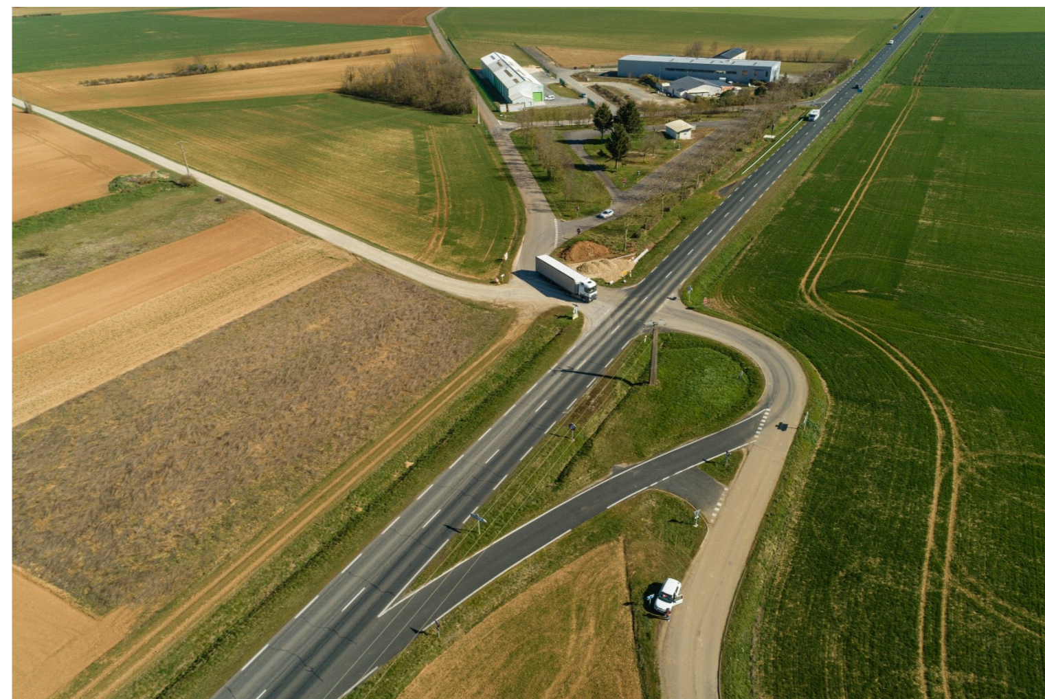
Carrefour entre la RN 151 et la RD 9A
