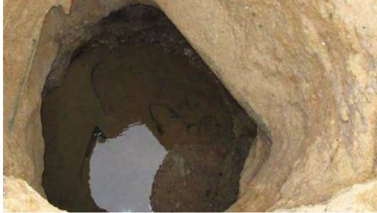
Illustration 14 : Effondrement survenu rue Berge à Romorantin-Lanthenay le 3 mars 2013 (photo : La Nouvelle République – 11 mars 2013).
