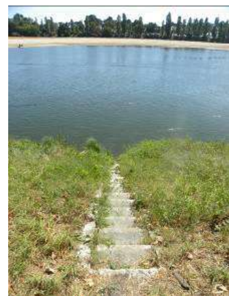
Vue vers l'escalier reliant la digue (ancien chemin de halage) et la Loire
