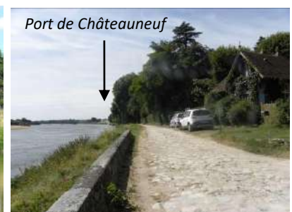
Vue vers l'aval, avec visibilité du port de Châteauneuf à partir du quai pavé du port de La Ronce
