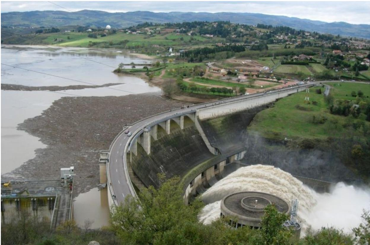
*Figure 18: La crue de novembre 2008 au barrage de Villerest – lors de cette crue, la moitié du débit entrant dans la retenue a été écrêtée (de près de 3 000 m<sup>3</sup>/s entrant, le débit est passé à 1 500 m<sup>3</sup>/s sortant) limitant fortement les débordements en aval*
