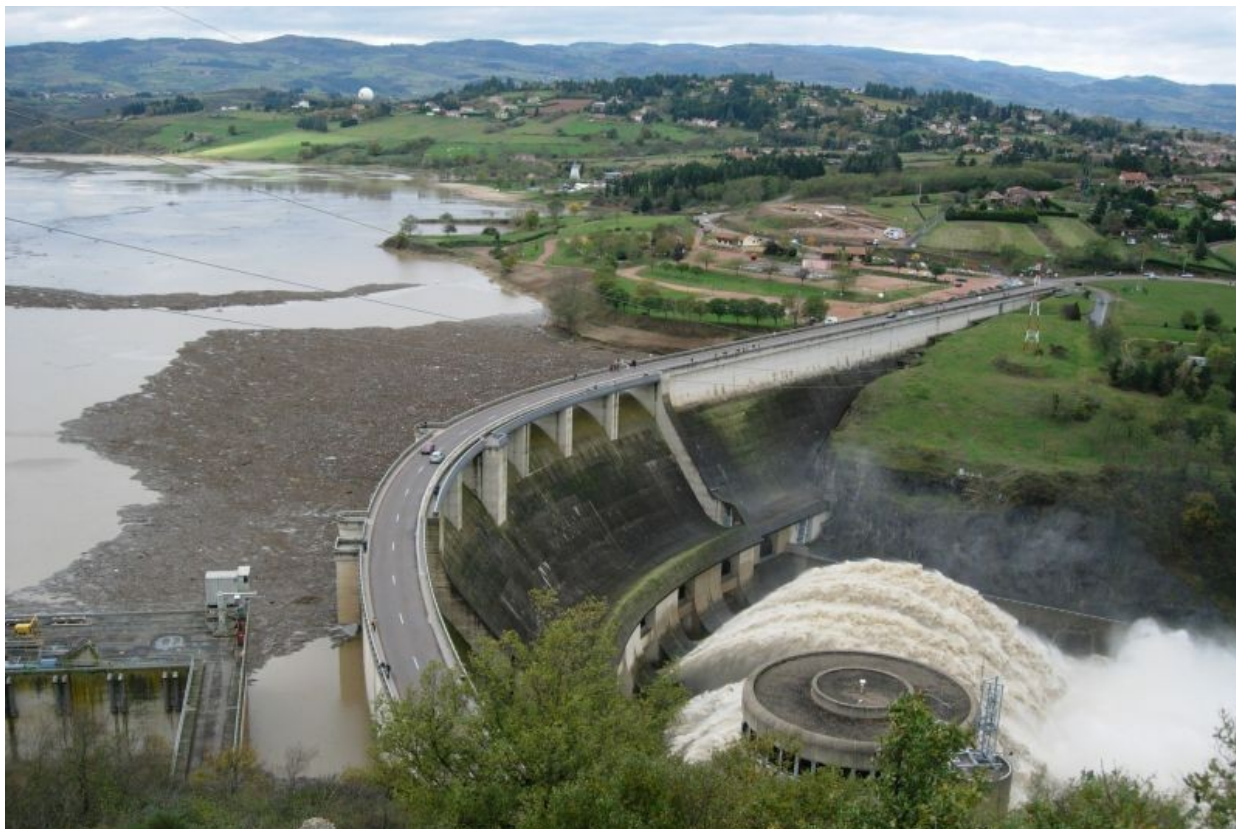
Figure 18: La crue de novembre 2008 au barrage de Villerest – lors de cette crue, la moitié du débit entrant dans la retenue a été écrêtée (de près de 3 000 m 3 /s entrant, le débit est passé à 1 500 m 3 /s sortant) limitant fortement les débordements en aval
