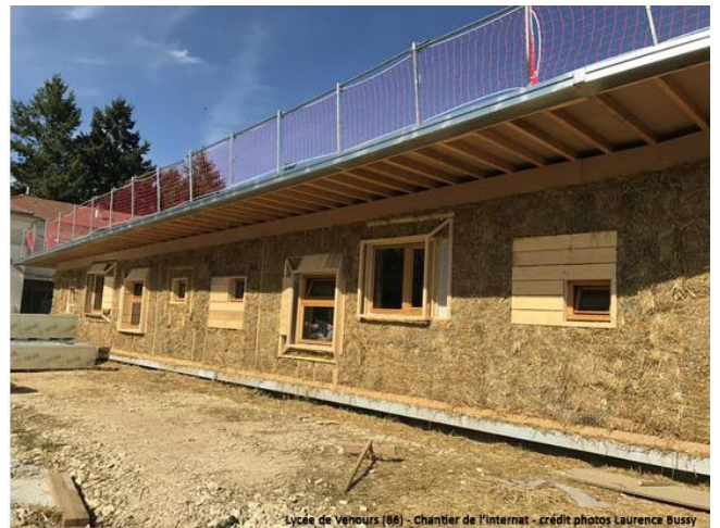
Lycée de Veneux (86) - Chantier de l'internat - crédit photos Laurence Bussy
