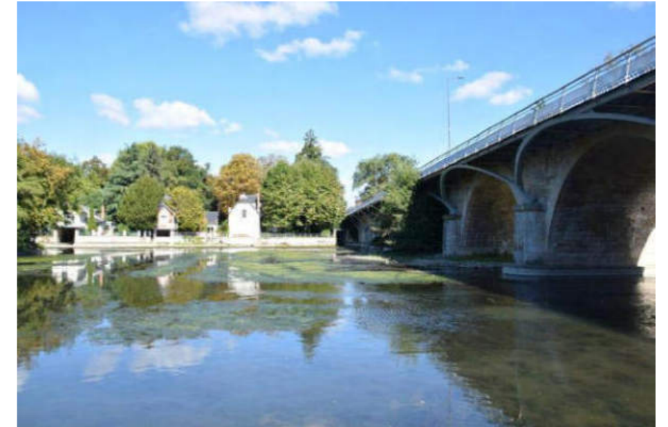
Le pont du Maréchal Leclerc sur le Loiret peut également être identifié comme un élément de la VUE. Il met en scène l'arrivée sur Olivet, et offre un point de vue de qualité sur les rives habitées de la rivière.
