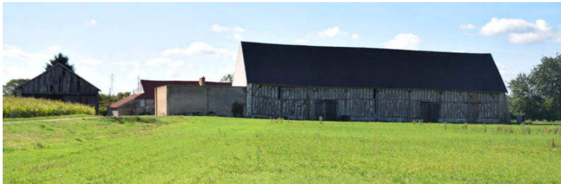
Rénovation d'une ancienne ferme et de sa grange en colombage dans la plaine à l'est d'Orléans
