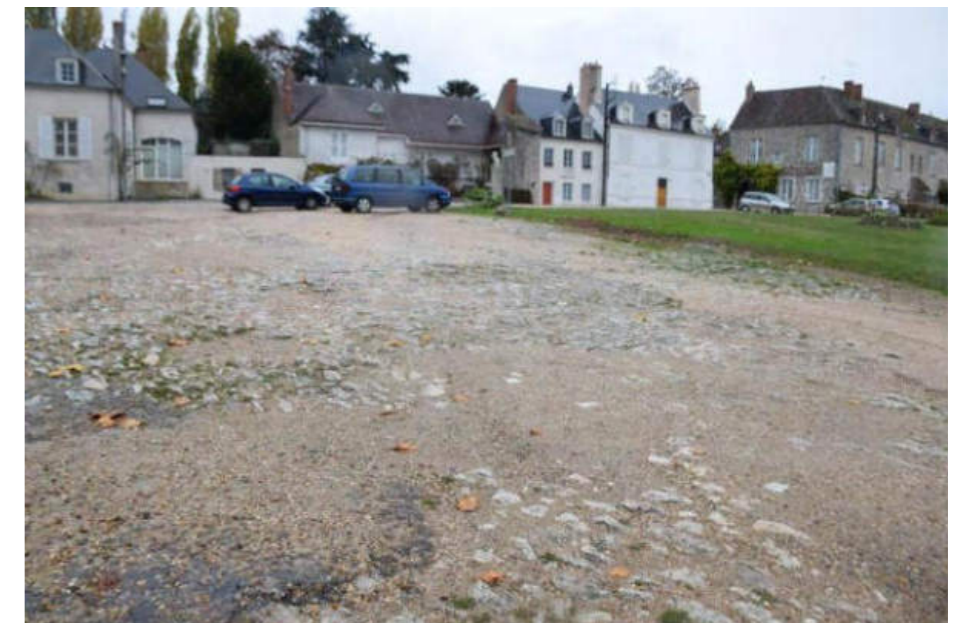
Le sol pavé des quais et de la cale de Meung-sur-Loire est abîmé par des réparations en enrobé
