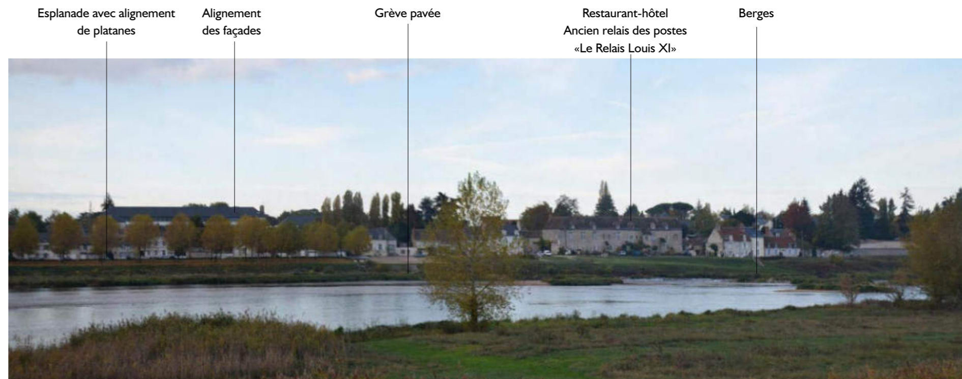
Front bâti de Meung-sur-Loire
