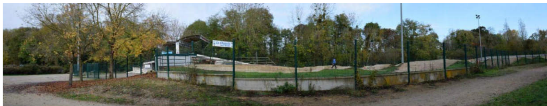
Les clôtures et le bâtiment du terrain de BMX ont un impact dégradant sur le paysage des berges
