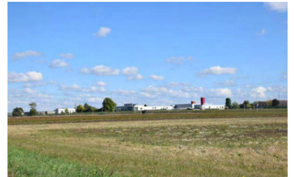
Le traitement des bâtiments d'activités ne sont pas pris en compte et constituent une menace au paysage emblématique du Val. Les couleurs, les matériaux utilisés, le manque de structures végétales sont des facteurs déterminants.
