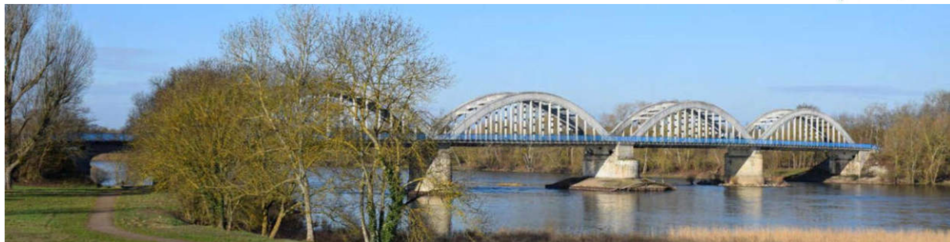
Pont de Muides-sur-Loire : Construit au XIXe siècle, il permet de franchir la Loire à Mer, de rejoindre la rive gauche, la commune de Muides puis le château de Chambord
