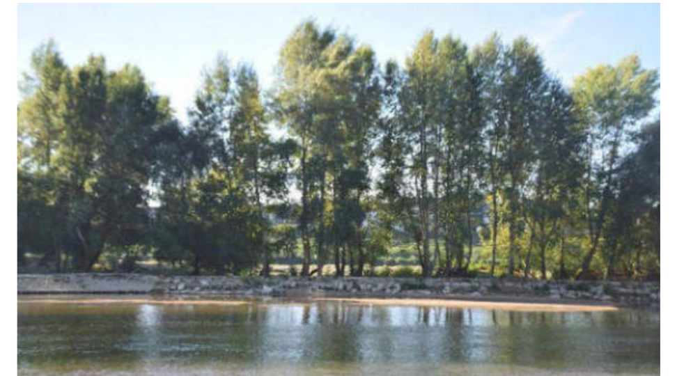
Certaines maçonneries s'écroulent car elles ne sont pas suffisamment entretenues, duits d'Orléans.
