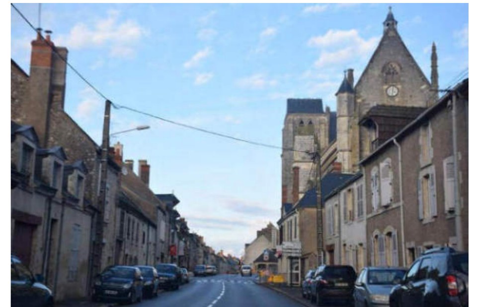
La forme urbaine dense, compacte et linéaire de Cléry-Saint-André qui s'organise sur le rebord de la terrasse alluviale le long de la RD951
