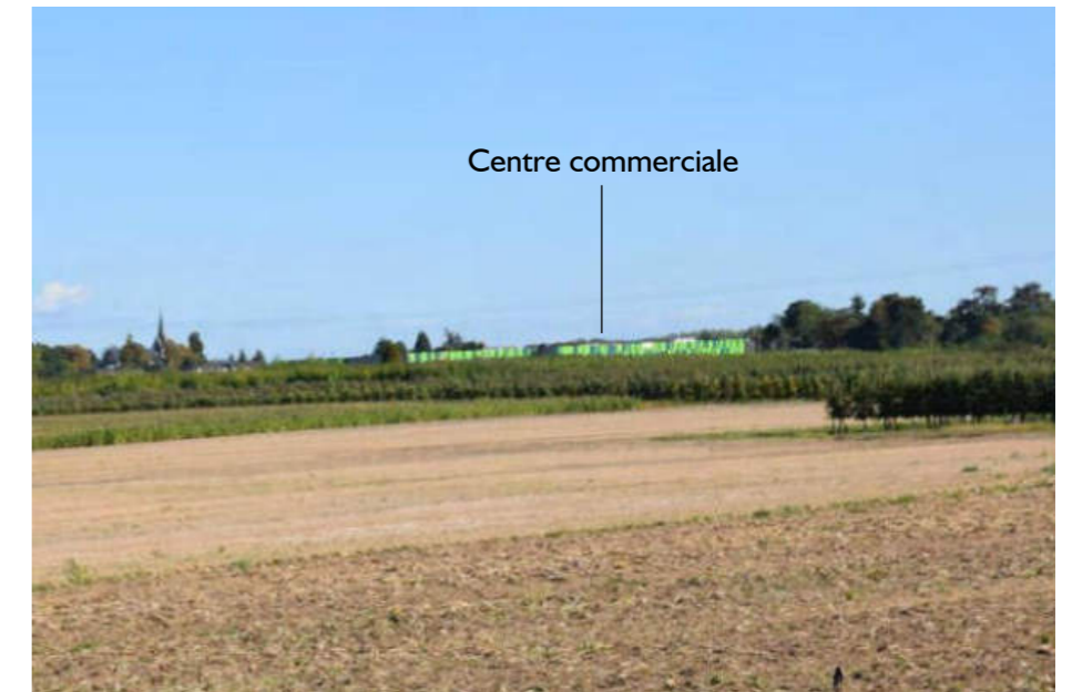
Le traitement des formes et des couleurs de certains bâtiments qui entachent le paysage de la V.U.E. Ici, l'utilisation du «vert pomme» artificialise complètement cette séquence de vergers de la plaine agricole.
