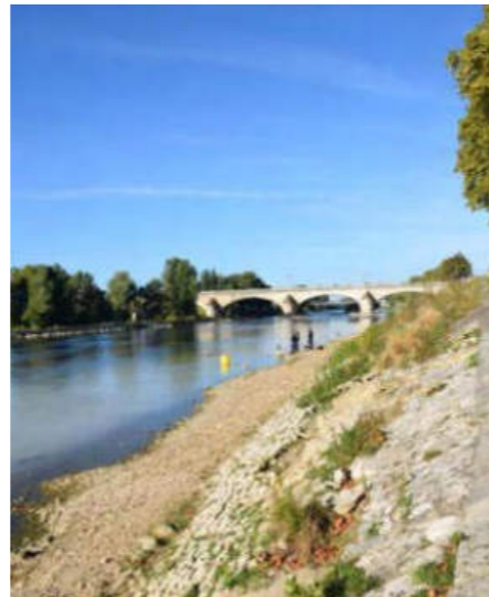
Parements qui se dégradent et végétation qui colonise, les ouvrages du port d'Orléans ne bénéficient pas d'un entretien suffisant.
