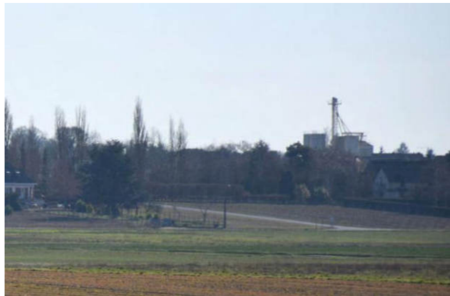
L'implantation et l'absence de qualification des abords du silo dévalorisent l'entrée du bourg de Saint-Claude-en-Diray depuis la RD 951.
