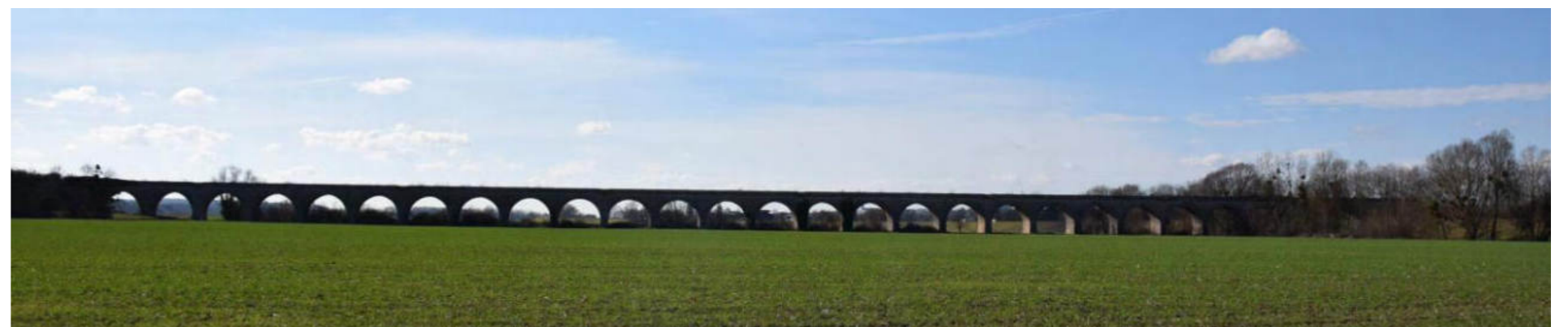
Viaduc de Vineuil, ligne ouvragée traversant le Val
