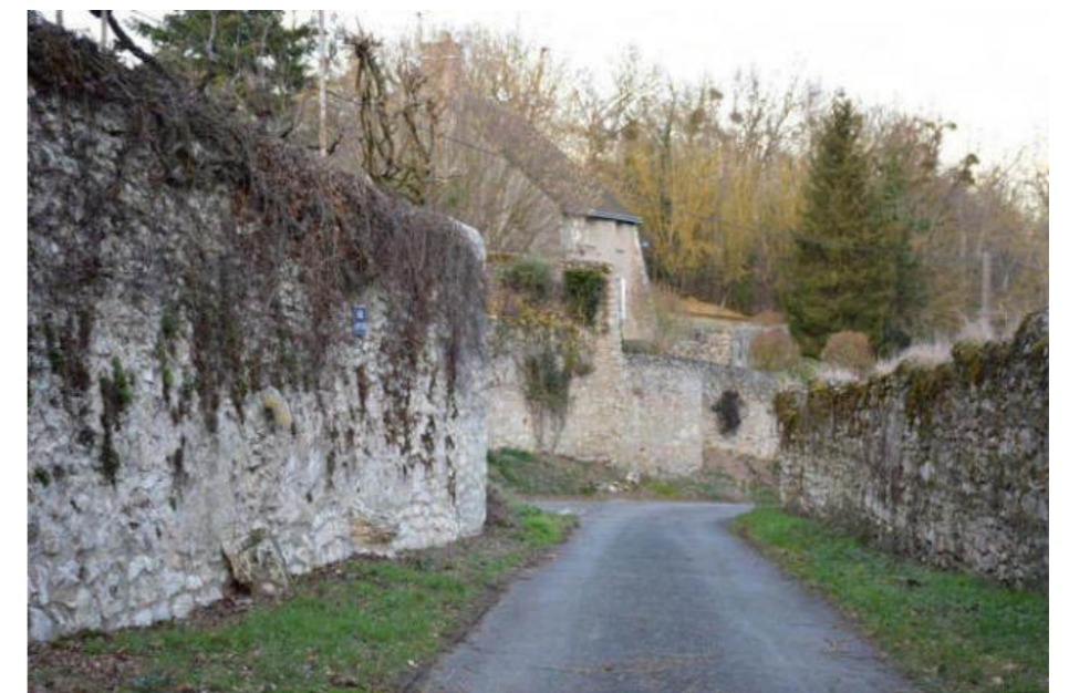
Organisés dans la pente, les villages présentent de beaux ouvrages de soutènement qui participent à la qualité paysagère des cœurs de villages. Cour-sur-Loire
