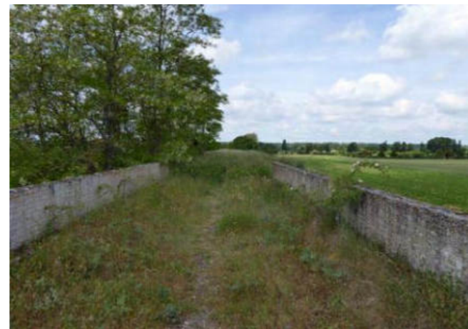
Point de vue depuis le cheminement du viaduc
