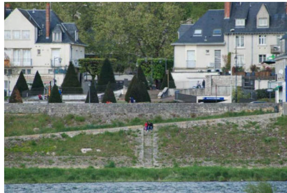
Le manque d'entretien des quais, perrés, escaliers fragilise les ouvrages. Par ailleurs, la végétation spontanée qui se développe rend ces derniers peu avants et difficilement appropriables par les habitants - source : Plan de Paysage de Agglopolys
