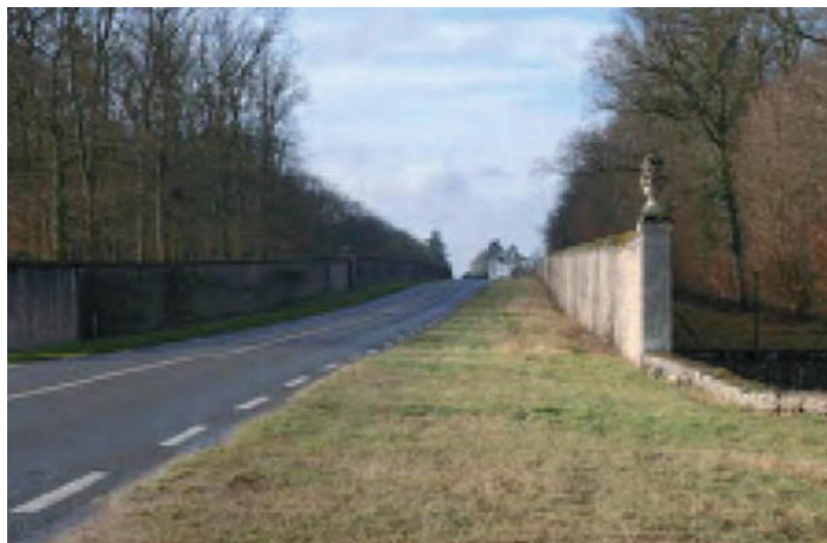
Traversée de Ménars par la RD2152, bordée du mur d'enceinte du parc du château - source : Atlas des paysages du Loir et Cher
