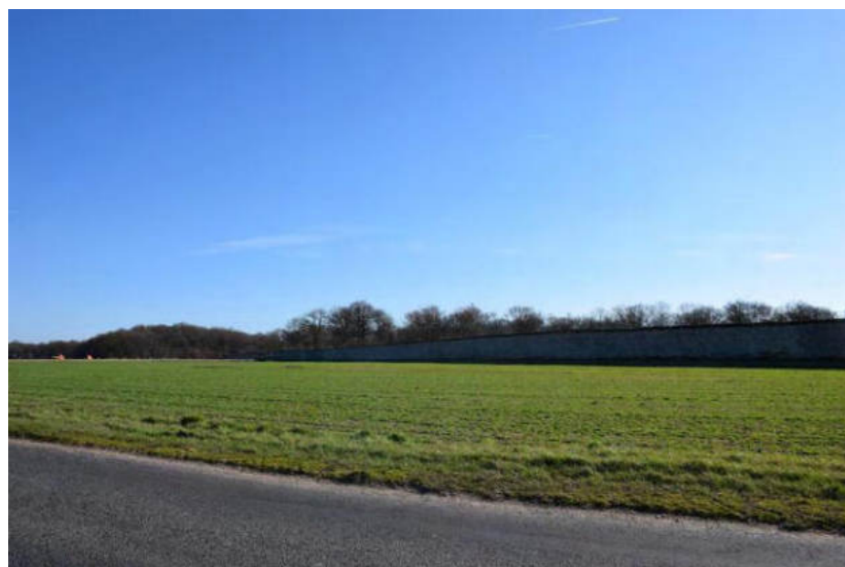
Le mur d'enceinte à Muides-sur-Loire
