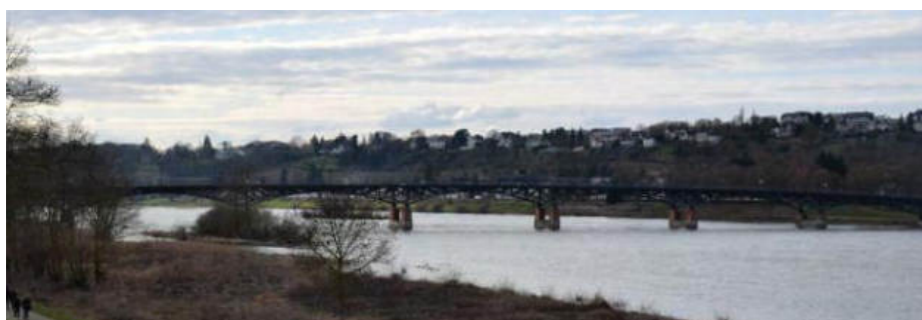
Pont Mitterrand à Blois
