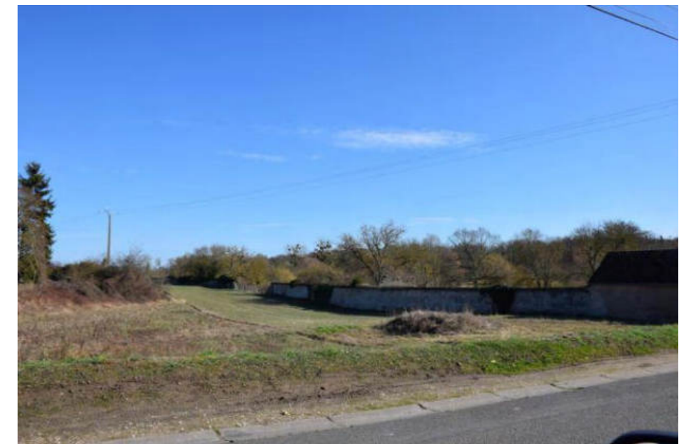
Mur d'enceinte de Chambord fragilisé, La-Chaussée-le-Comte
