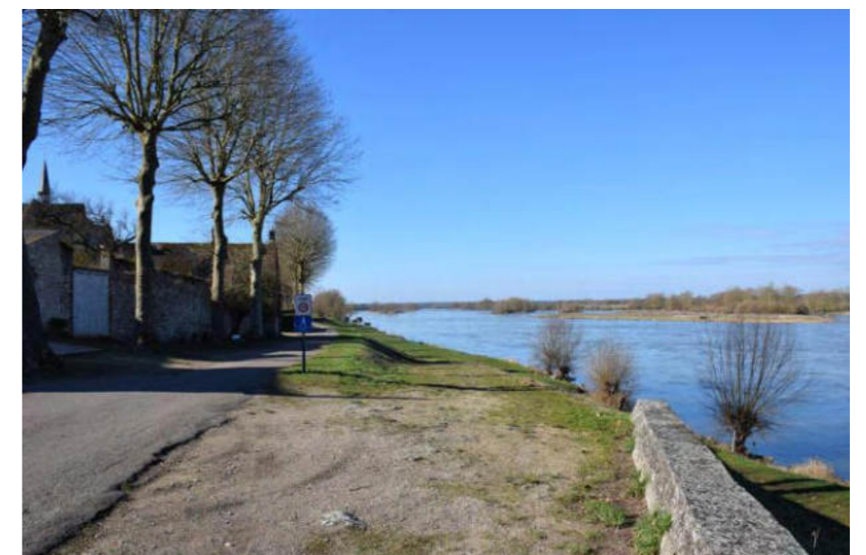
Les ouvrages du port de Saint-Dyé-sur-Loire ne bénéficient pas d'un entretien suffisant : dégradation des parements, colonisation de la végétation.
