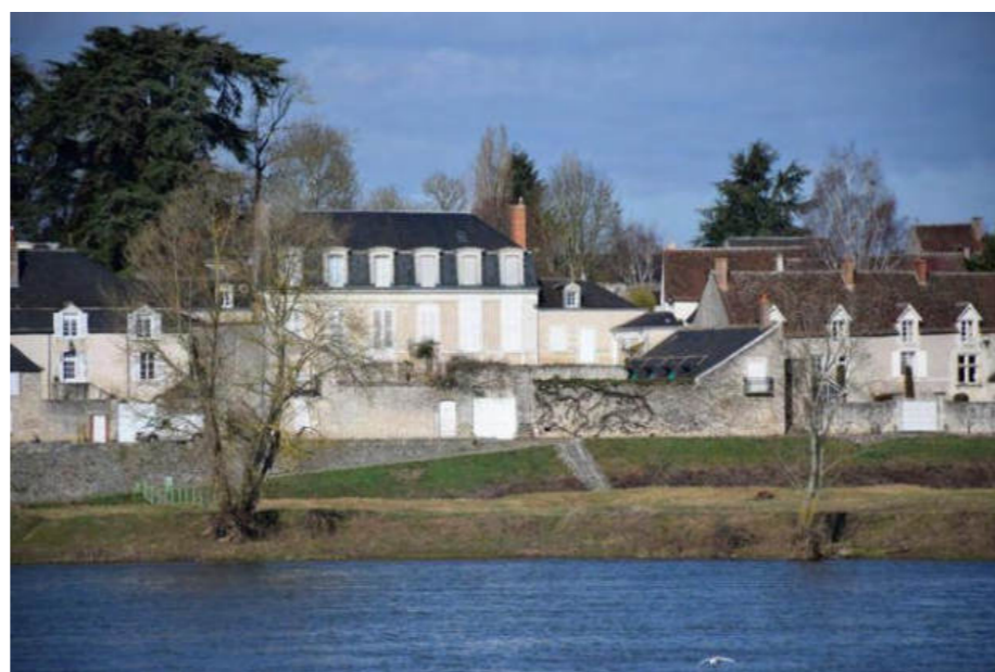
Rampe d'accès à l'eau, escaliers, quais maçonnés, port de Cour-sur-Loire.
