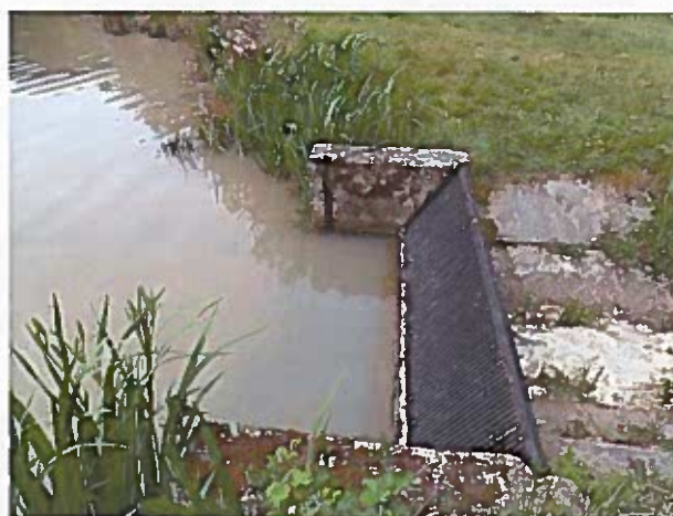
Photo 4 : Grille à l'entrée de la surverse
