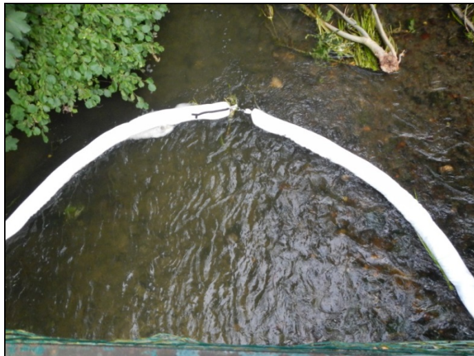
Figure 12 : Barrage filtrant et absorbant mis en place sur la totalité du lit mineur
