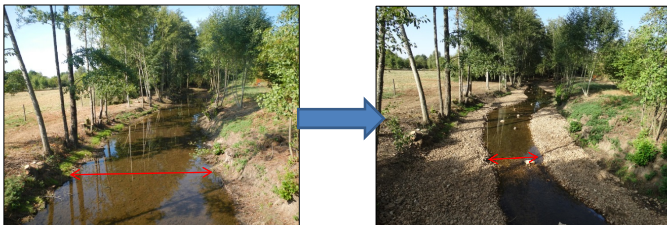
Figure 6 : Exemple de restauration morphologique menée sur l'Ozanne par la Fédération de pêche. Rétrécissement de la section d'écoulement et création d'un nouveau lit d'étiage.
