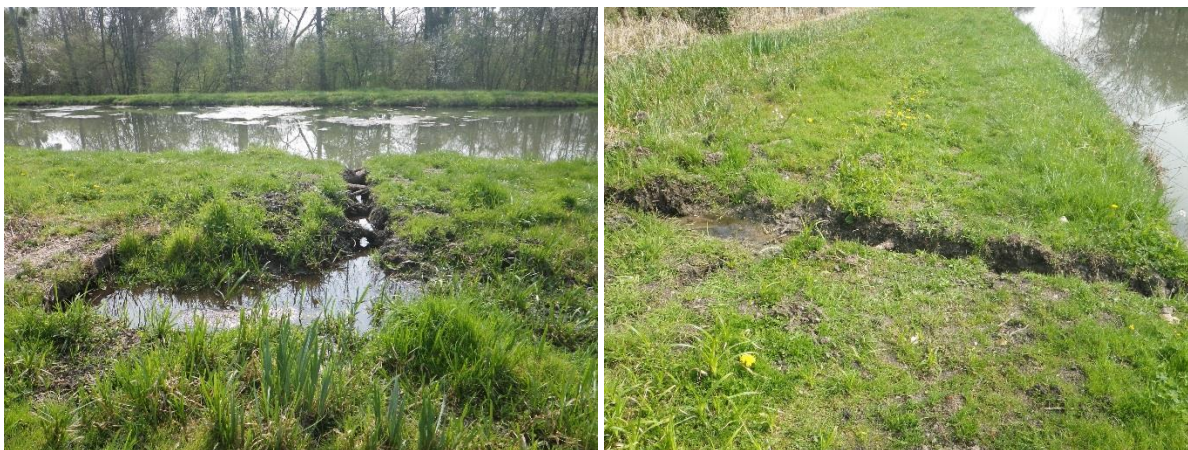
Figure 7 : Exemples de tranchées réalisées en crête
