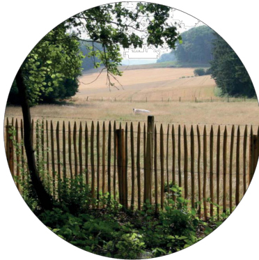
Ganivelle en échelas de chataignier : fendu, scié quart de rond, lattes sciés, carrés etc.
