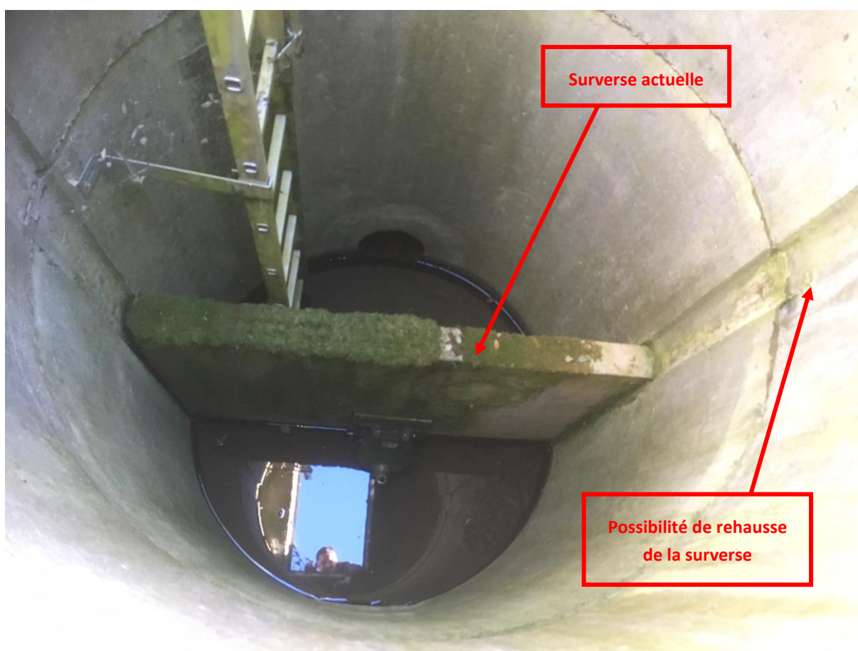
Photo 1 : Ouvrage de régulation et surverse (source : BIA Géo)
