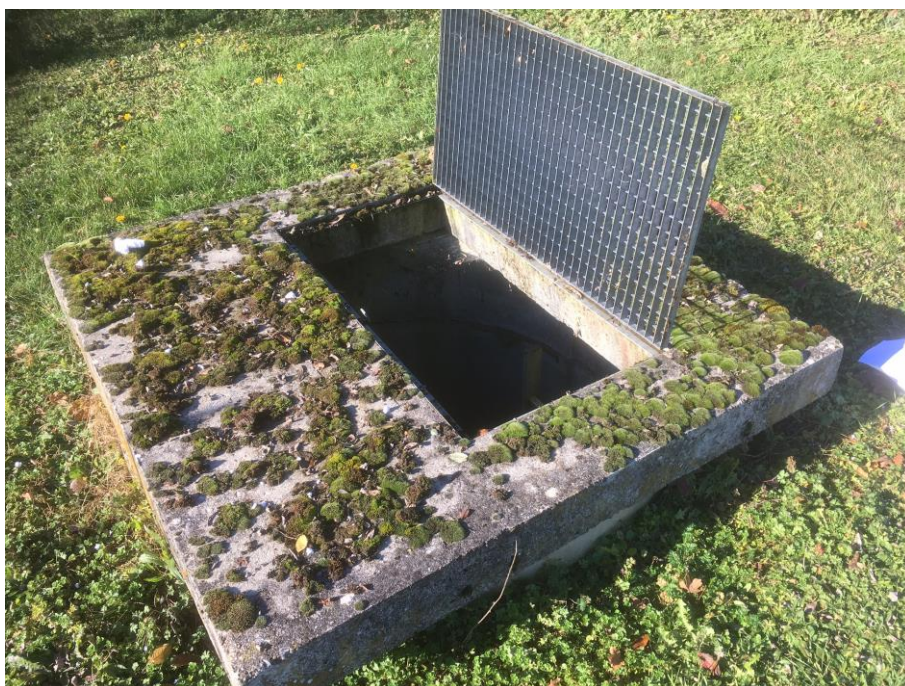
Photo 2 : Regard de l'ouvrage de sortie (source : BIA Géo)
