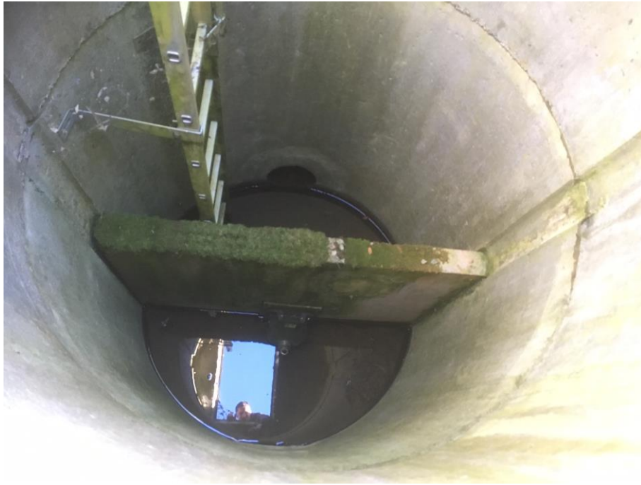
Photo 3 : Ouvrage de régulation et surverse (source : BIA Géo)
