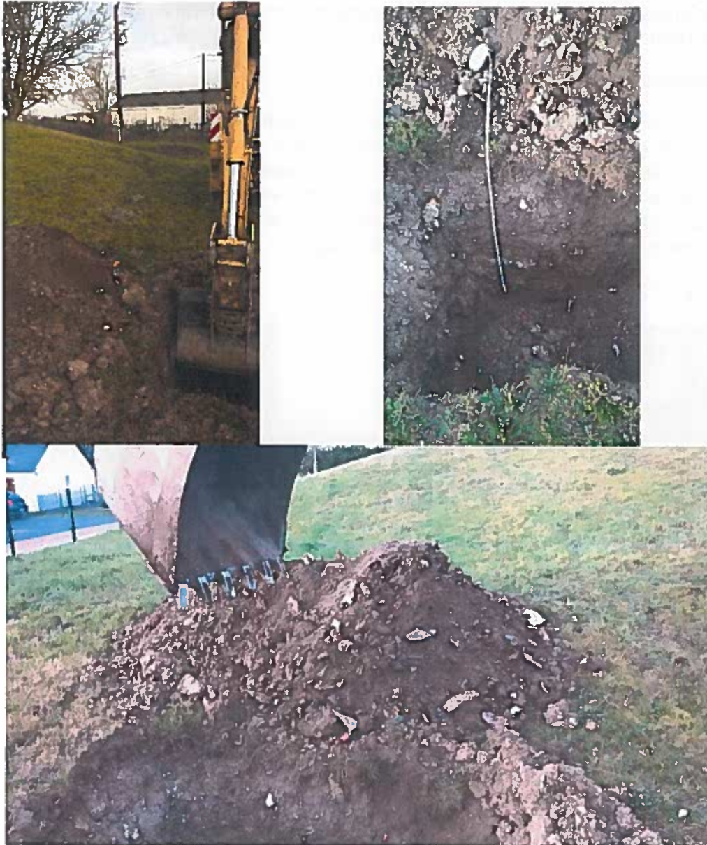
Sondage n°2 – Implantation et sondage à la pelle mécanique (10/01/2017)
