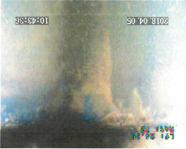
Réduction diamètre colonne d'exhaure
