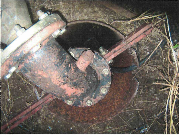
Forage tube en acier 457mm. Tête de forage = repère des mesures vidéo.
