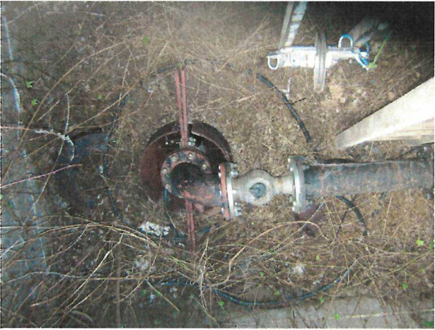
Vues de l'avant puits maçonné en parpaings de 14/15cm. 2,80m x 1,95m.
