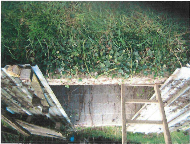
Vues de l'avant puits maçonné en parpaings de 14/15cm. 2,80m x 1,95m.
