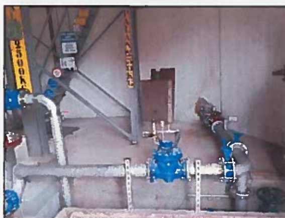
Photo 4 : Refoulement du captage et caniveau technique
