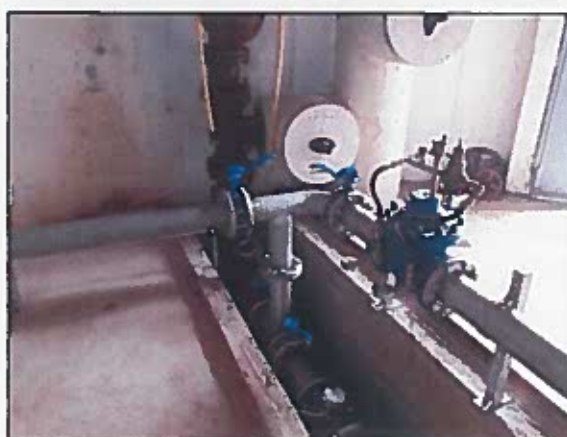
Photo 6 : Refoulement du captage et caniveau technique
