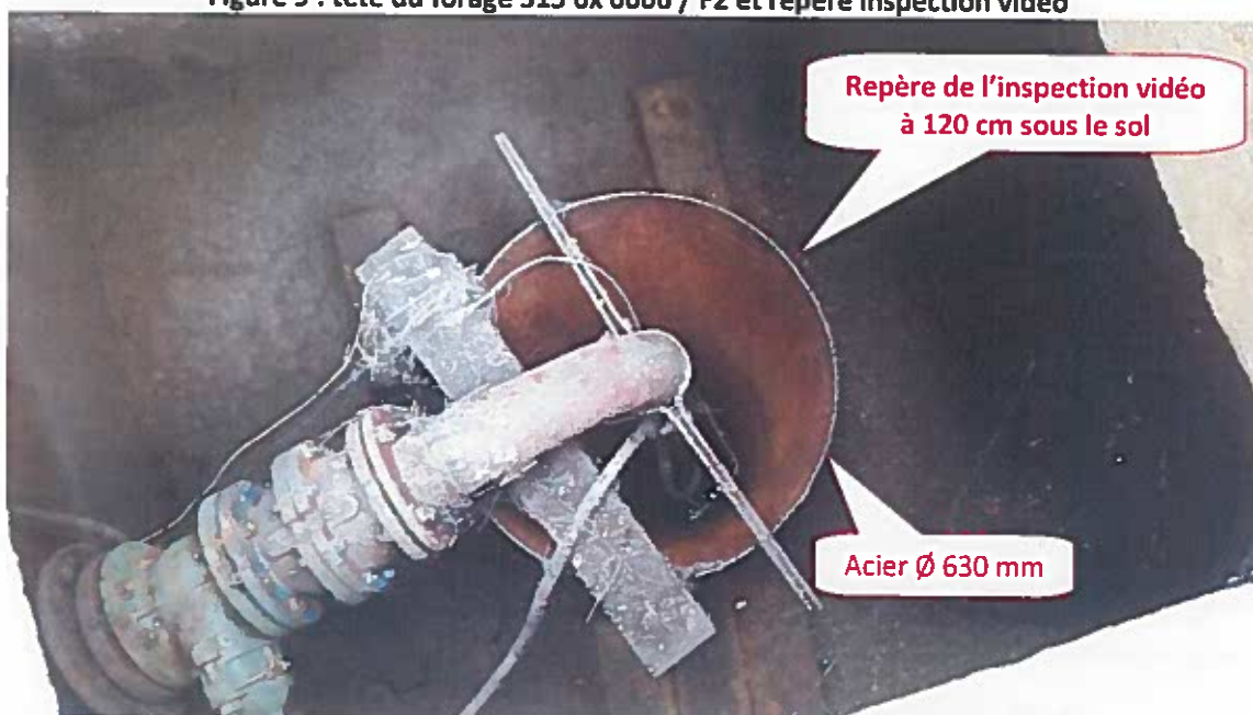
Figure 9 : tête du forage 515 6x 0006 / F2 et repère inspection vidéo
