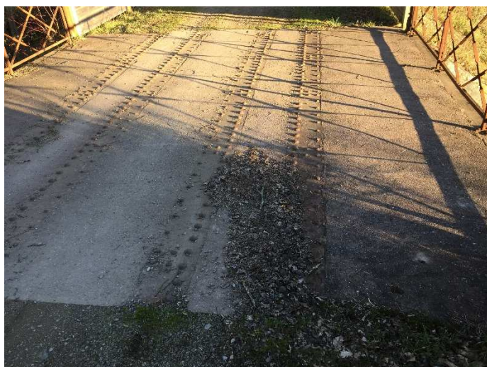
Exemple d'un pont rails métallique bétonné et rencontré sur la Voie Verte d'Argenton-sur-Creuse
