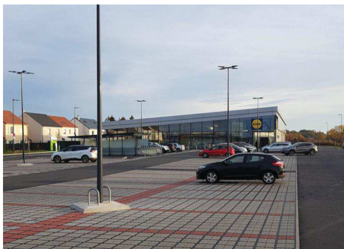
Figure 15 : Exemple de places de stationnement perméables en pavés drainants (système ECOVEGETAL)
