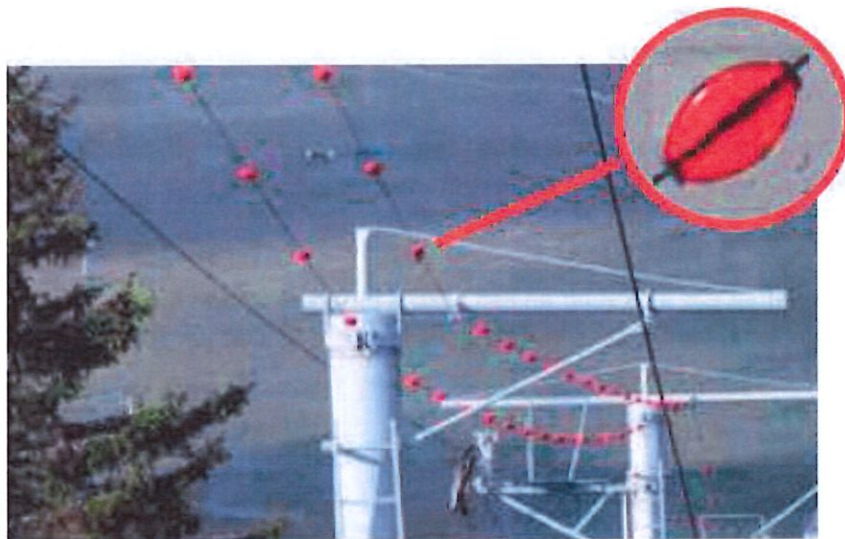
Photo : Exemple de dispositifs anti-collisions (type « flotteur/fanions ») à disposer tous les 3 à 5m)
