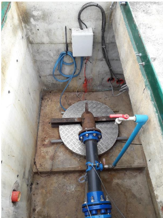
Photo 1 :Local du forage d'exploitation avec robinet de prélèvement
