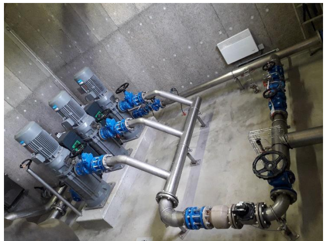
Photo 8 : 3 Pompes de reprises vers le château d'eau
