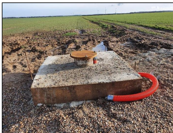
Tête de forage et dalle de protection (margelle) mise en place peu après la réalisation de l'ouvrage (Photographies : M r Christophe BINEY – Déc-20)
