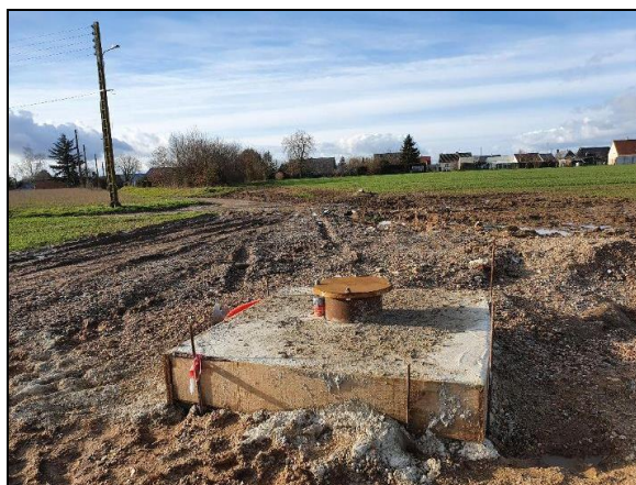
Tête de forage et dalle de protection (margelle) mise en place peu après la réalisation de l'ouvrage (Photographies : M r Christophe BINEY – Déc-20)
