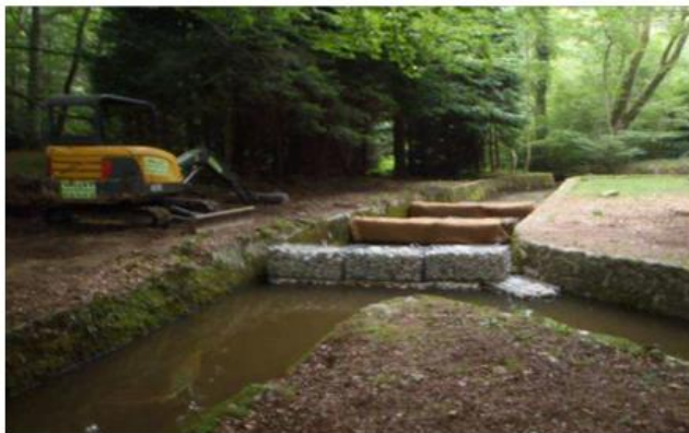
Figure 6 : Exemple de filtres en gabion de galets recouvert de géotextile (vidange du barrage du Lampy, GEOS 2019)
