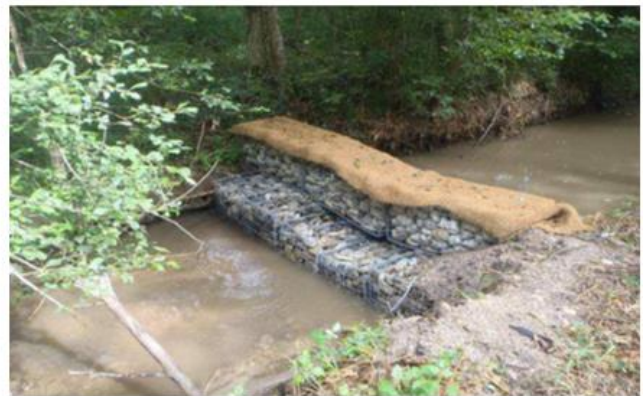
Figure 6 : Exemple de filtres en gabion de galets recouvert de géotextile (vidange du barrage du Lampy, GEOS 2019)
