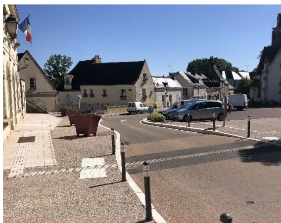
Fil d'Arianne continu entre le stationnement PMR et la Mairie, bandes podotactiles, abaïssement du trottoir et plots avec couleurs contrastées au niveau de la traversée piétonne.
