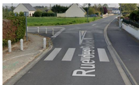
Traversée piétonne non réglementaire rue des Belles Maisons, sans abaïssée de trottoir, plots, ni bandes podotactiles
