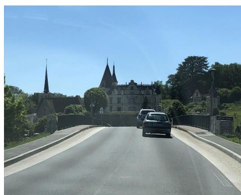
Chaussée à voie centrale banalisée sur la RD85 franchissant le Cher à Véretz
