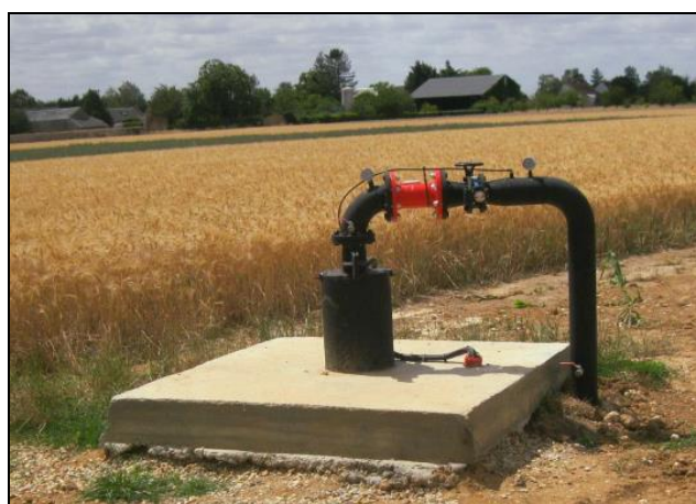
Exemple d'aménagement de tête de forage avec équipement d'hydraulique à l'exhaure dédié à l'irrigation de cultures (Photographie : GéoSen – Juil-20)
