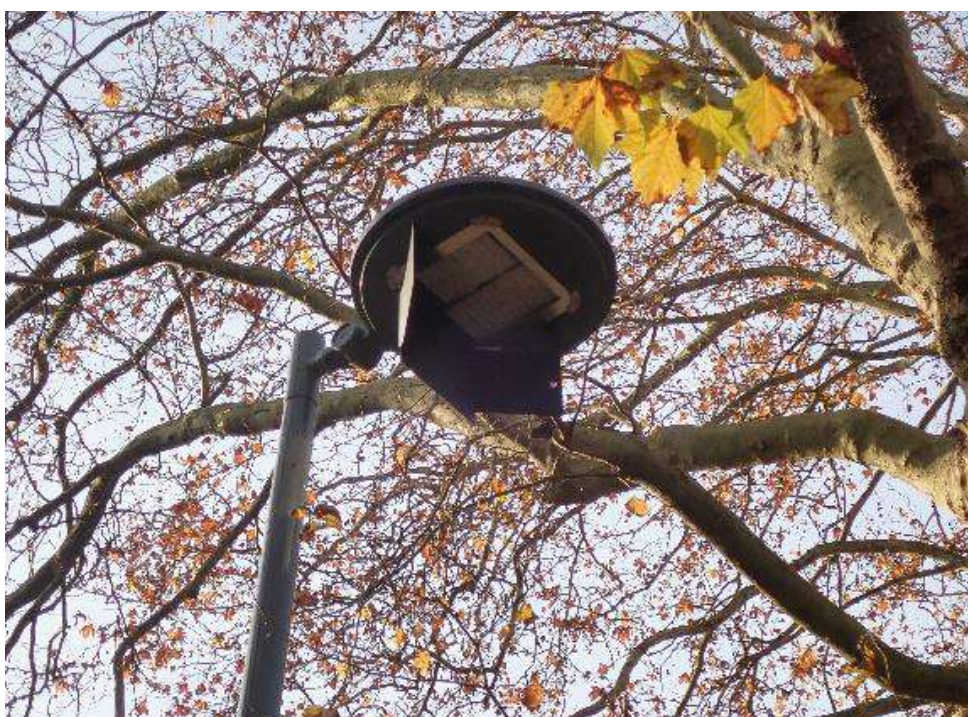
Figure 24 – Luminaire éclairant vers le bas et cache permettant d'orienter la lumière vers l'endroit voulu, Parc de la Citadelle à Lille, © Sarah Miccoli
