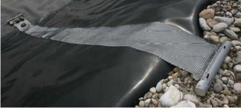
Figure 26 – Echappatoire installé sur un bassin, le géotextile placé sous la grille permet de préserver la membrane imperméable du bassin. Crédit : Jardins solidaires
