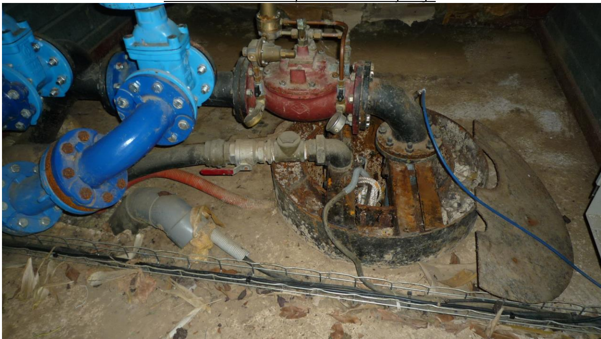
Vue sur la tête de puits du forage
