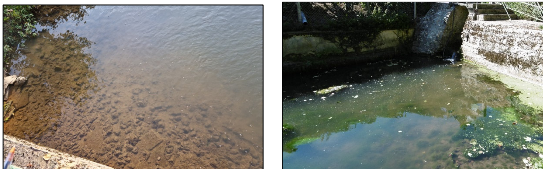
Figure 13 : Colmatage du Trompe-Souris en aval du vannage de décharge
