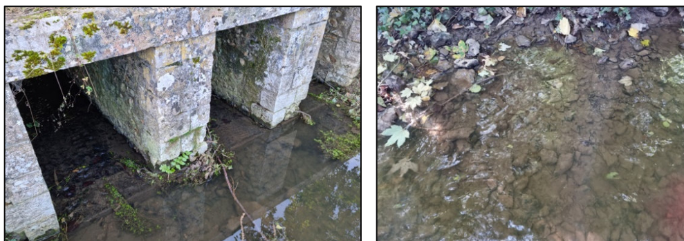
Figure 12 : radier surélevé du pont de la rue La Brosse
