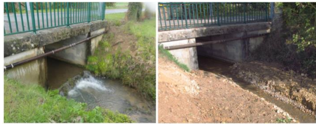
Figure 31 : rétablissement de la continuité par rehaussement du lit (SIVY, 2017)
