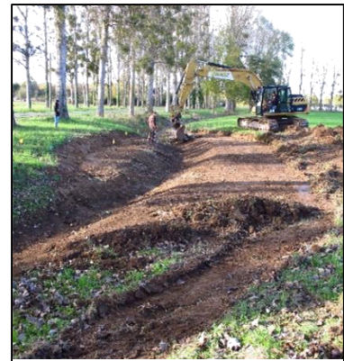
Figure 28 : Restauration de frayère à Brochet sur le Moulon (SIVY, 2017)
