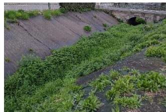
Figure 43 : bâchage d'une portion du lit de la Papelourde à Saint-Doulchard
