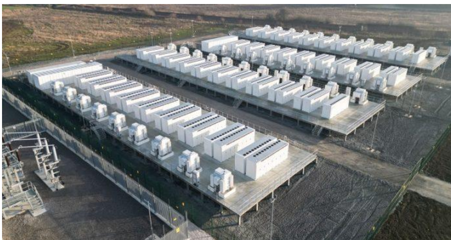
Figure 4 - Station de stockage d'électricité de Pillswood (Royaume-Uni), connecté au réseau électrique en novembre 2022, pour une puissance de 98MW, une capacité de 196 MWh et une emprise de 1ha. Les conteneurs ont été placés sur une plateforme surélevée afin de prévenir du risque de submersion présent sur site (source : business scotland magazine)
