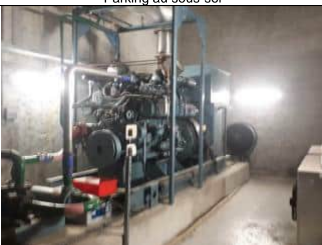
Groupe électrogène
