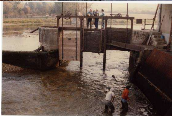
Photographies – Vannes de décharge
