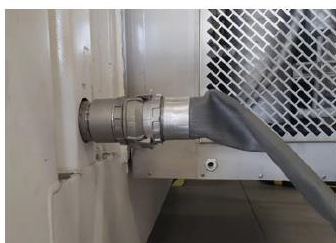
Figure 27 : Illustration du branchement permettant l'inondation du container ainsi que la pulvérisation d'eau
