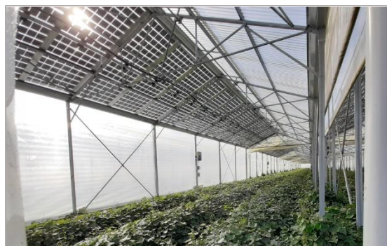
Serre photovoltaïque de Grisolles (82). Passage de lumière versant Sud 17%.
