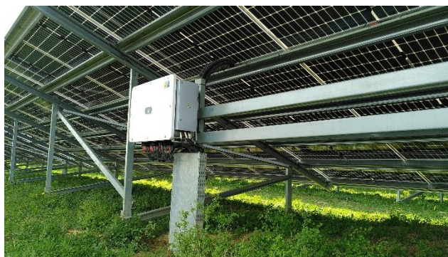
Figure 19 : Exemple d'onduleur accroché derrière les tables de modules
