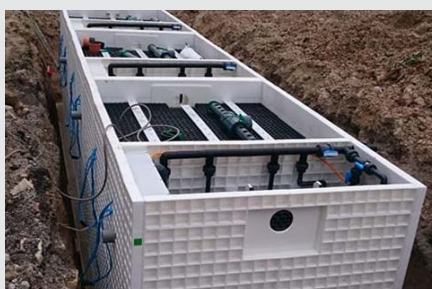
► Station d'épuration pendant l'installation.
