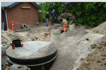
► Installation combinée avec un bassin de décantation et un réservoir tampon en PRV.
