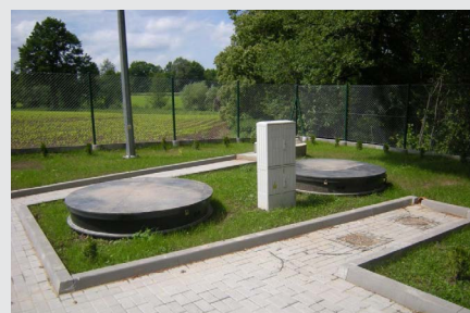
► Installation avec bassin de décantation et réservoir tampon déportés pour s'adapter à un espace restreint.
