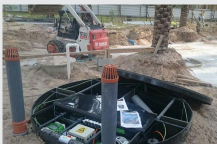
► Station d'épuration pendant l'installation.
