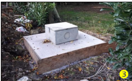
❷ Exemples d'aménagement de tête de forages dédiés à l'irrigation de cultures et aux besoins des cheptels
