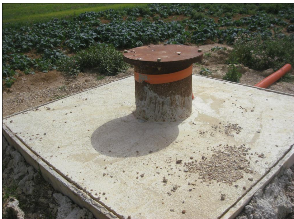
Tête de forage (Colonne Acier) et margelle du forage réalisé pour M. Didier BERTRAND
