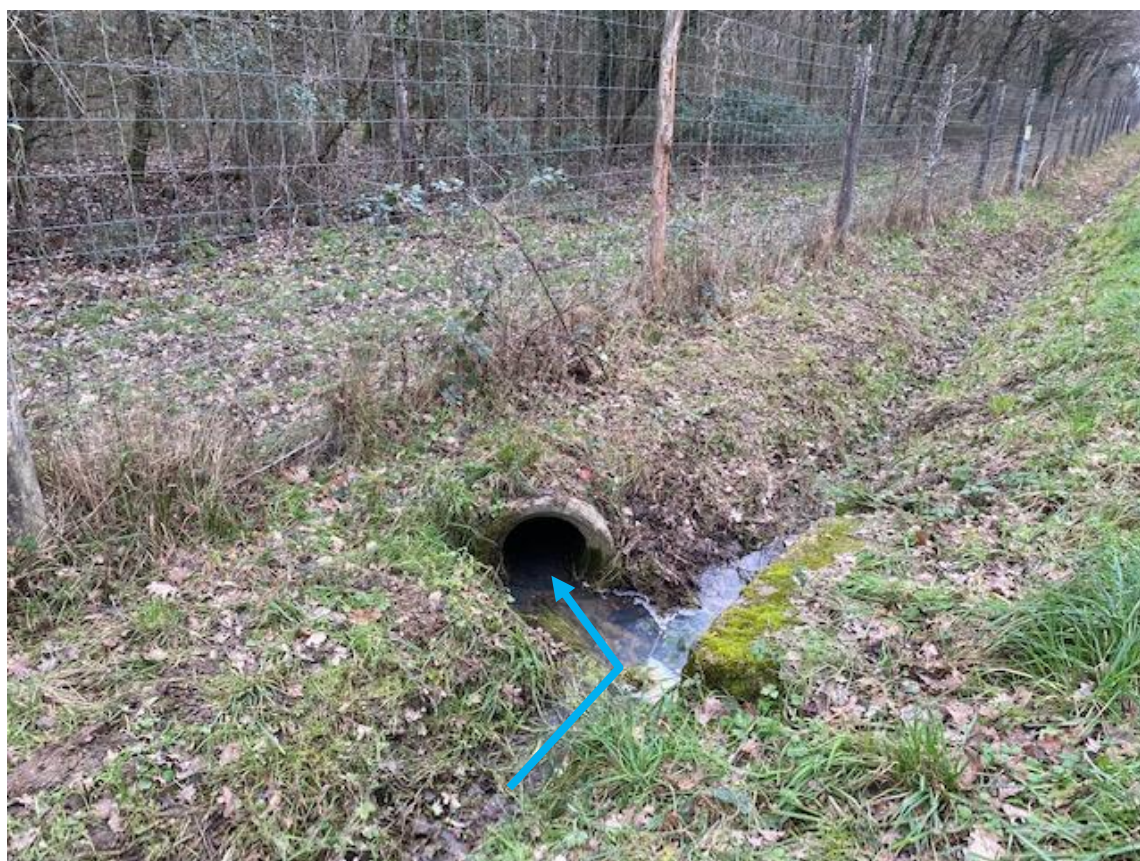
Figure 7 : Vue du busage (Ø 400 mm béton) du petit ru et recueillant les eaux du fossé de la RD 320 vers la chaîne d'étang du ru affluent de la Sange
