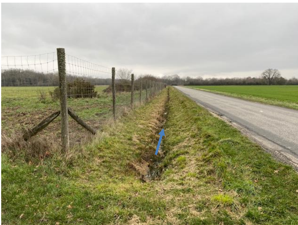
Figure 5 : Vue en direction de l'Est – Fossé longeant la RD 320 et évacuant les eaux de pompage tests vers le ru affluent de la Sange
