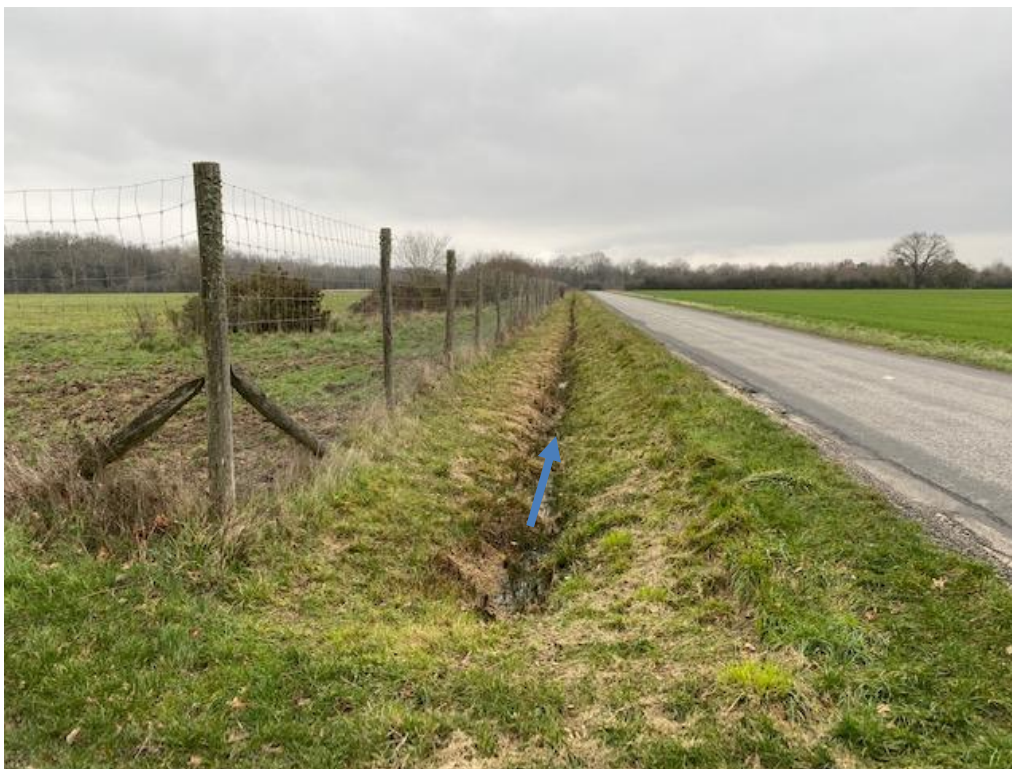
Figure 5 : Vue en direction de l'Est – Fossé longeant la RD 320 et évacuant les eaux de pompage tests vers le ru affluent de la Sange
