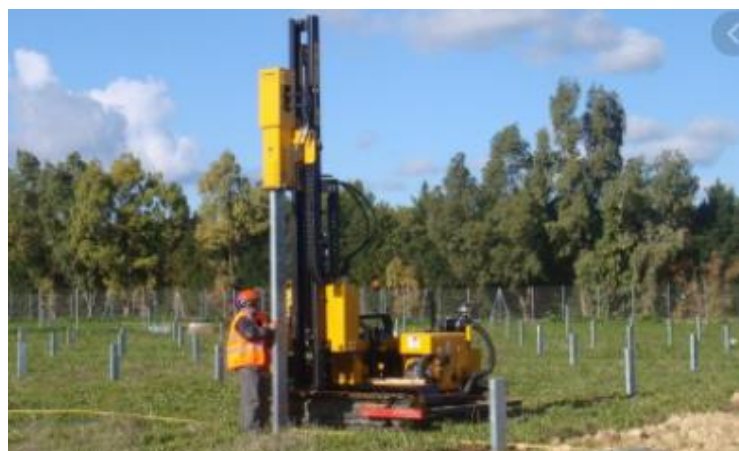
Figure 13. Ancrage des pieux battus
