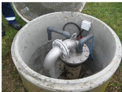
Illustration 22 : Exemple de tête de puits avec tête de forage étanche
