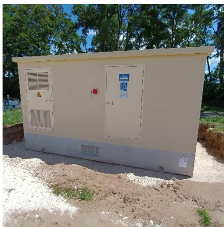
Figure 3 : Poste de livraison prévu pour ce type de projet
