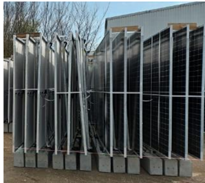
Figure 1 : blocs stockés verticalement avant installation
