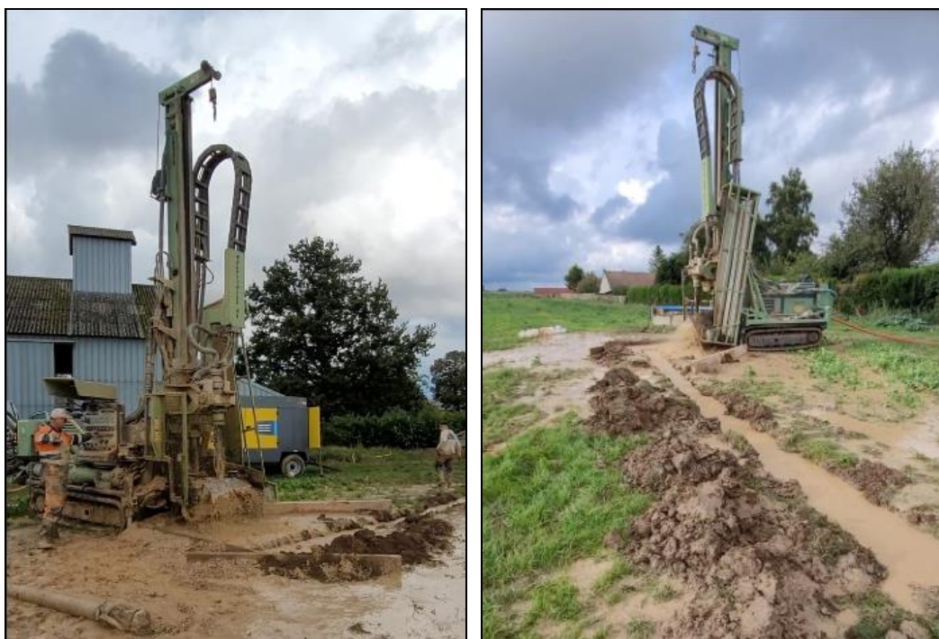
Sondage de reconnaissance réalisé jusqu'à 49 m /sol pour M r Fabien SEIGNEURET en septembre 2024 par la S.A.S. GTR FORAGES (61 100 – MONTILLY-SUR-NOIREAU) (Photographies : Monsieur Fabien SEIGNEURET)
