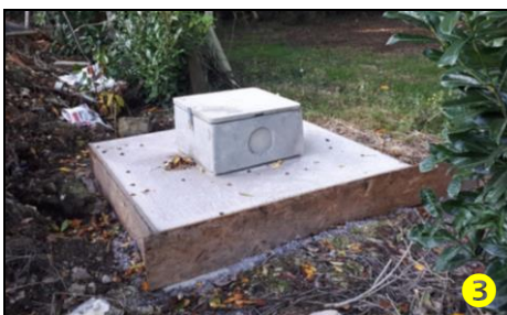
❷ Exemples d'aménagement de tête de forages dédiés à l'irrigation de cultures et aux besoins des cheptels
