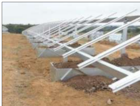
Exemple de parc photovoltaïque utilisant des fondations « gabions »
