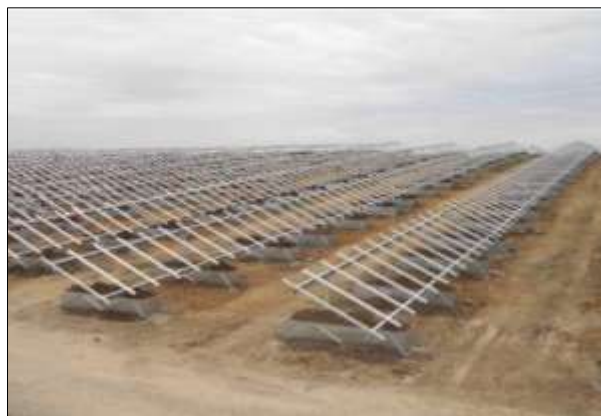
Exemple de parc photovoltaïque utilisant des fondations « gabions »
