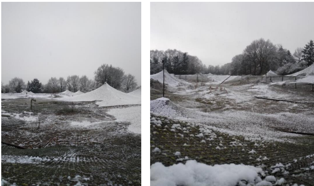
Photos des volières traditionnelles de Monsieur Puisset en cas d'épisode de neige à Sully sur Loire Le poids de la neige entraîne l'effondrement des volières et la nécessité de reconstruire
