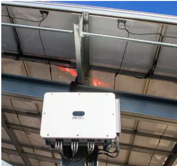
Figure 3.b.1 : Exemple onduleur sur ombrière
