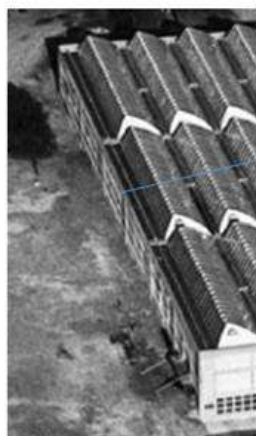
Vue aérienne de la construction : les sheds de la Salle du Conseil et l'habillage triangulaire de la Facade Nord sont prêts et empilés sur site pour son montage ; les pavillon « living-room » et les trois pavillons de « bureaux » sont déjà assemblés. Non datée. Clôté Albert Gerand, archives des entreprises MAME.
