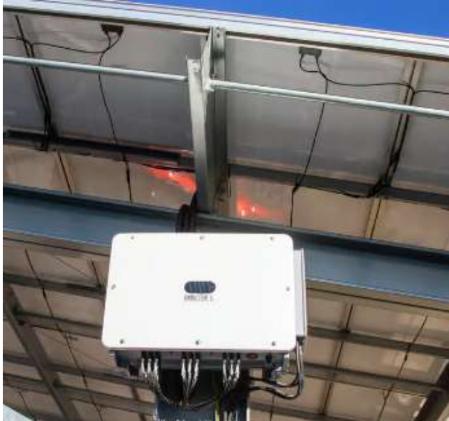
Figure 3.b.1 : Exemple onduleur sur ombrière
