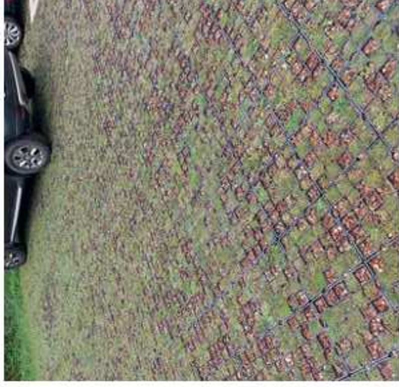
Plaques alvéolées plastique préensemencées d'un mélange de plantes adaptées à la circulation et au piétement pour stationnement drainant végétalisé et facile d'entretien
