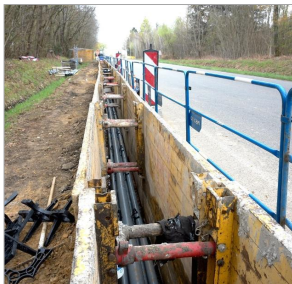
Figure 4 | Pose des fourreaux PEHD en milieu rural et PVC en bordure de voirie
