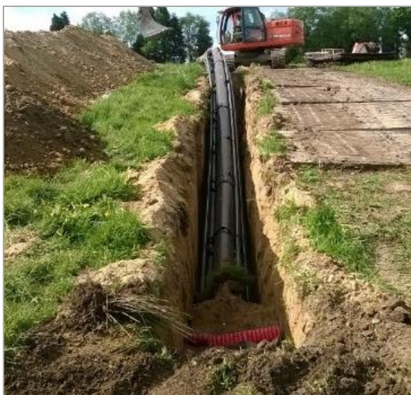
Figure 4 | Pose des fourreaux PEHD en milieu rural et PVC en bordure de voirie
