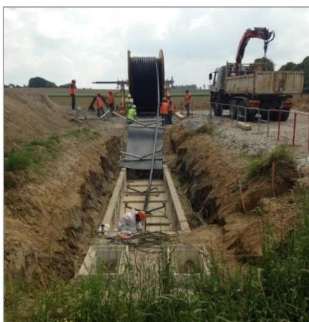
Figure 5 | Déroulage d'un câble souterrain au niveau d'une jonction (à gauche) et réfection d'une chaussée après travaux (à droite)
